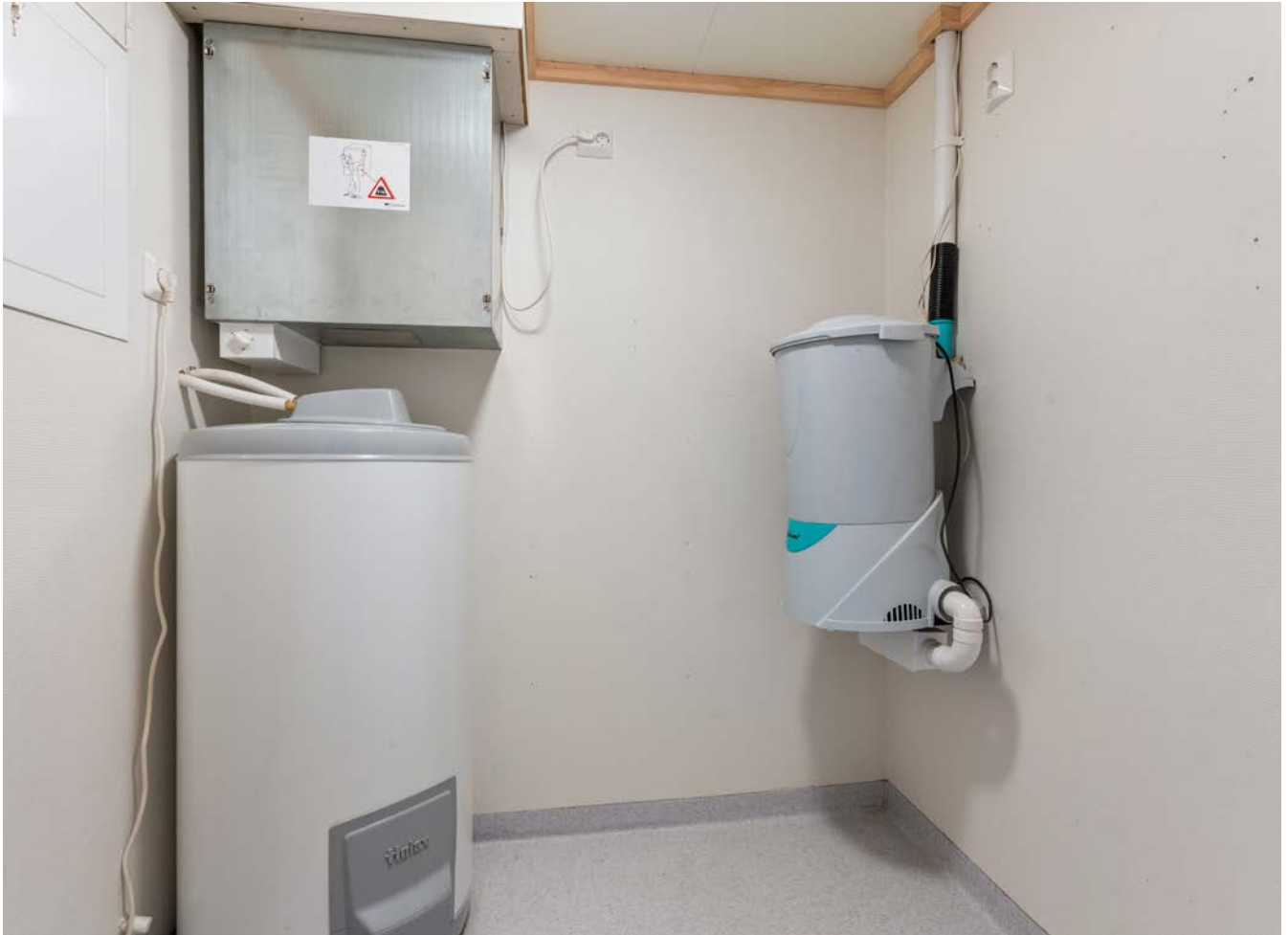
Bod - teknisk rom. Ventilasjon, sentralstøvsuger og rør i rør
