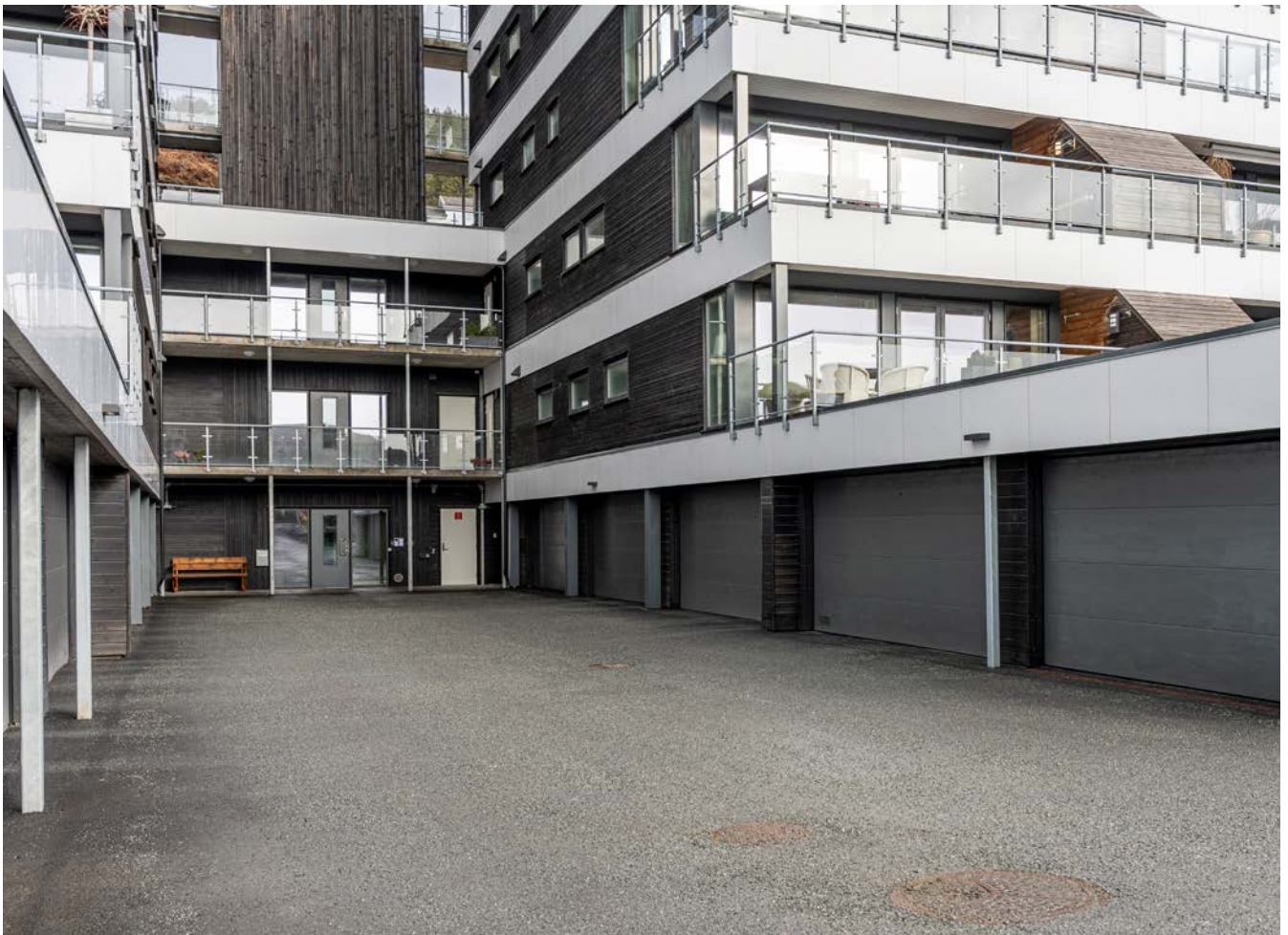
Inngangsparti og garasjer
