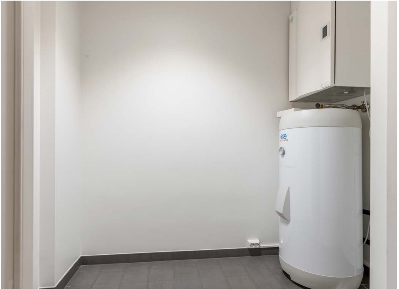
Tekn. rom / vaskerom/ bod
