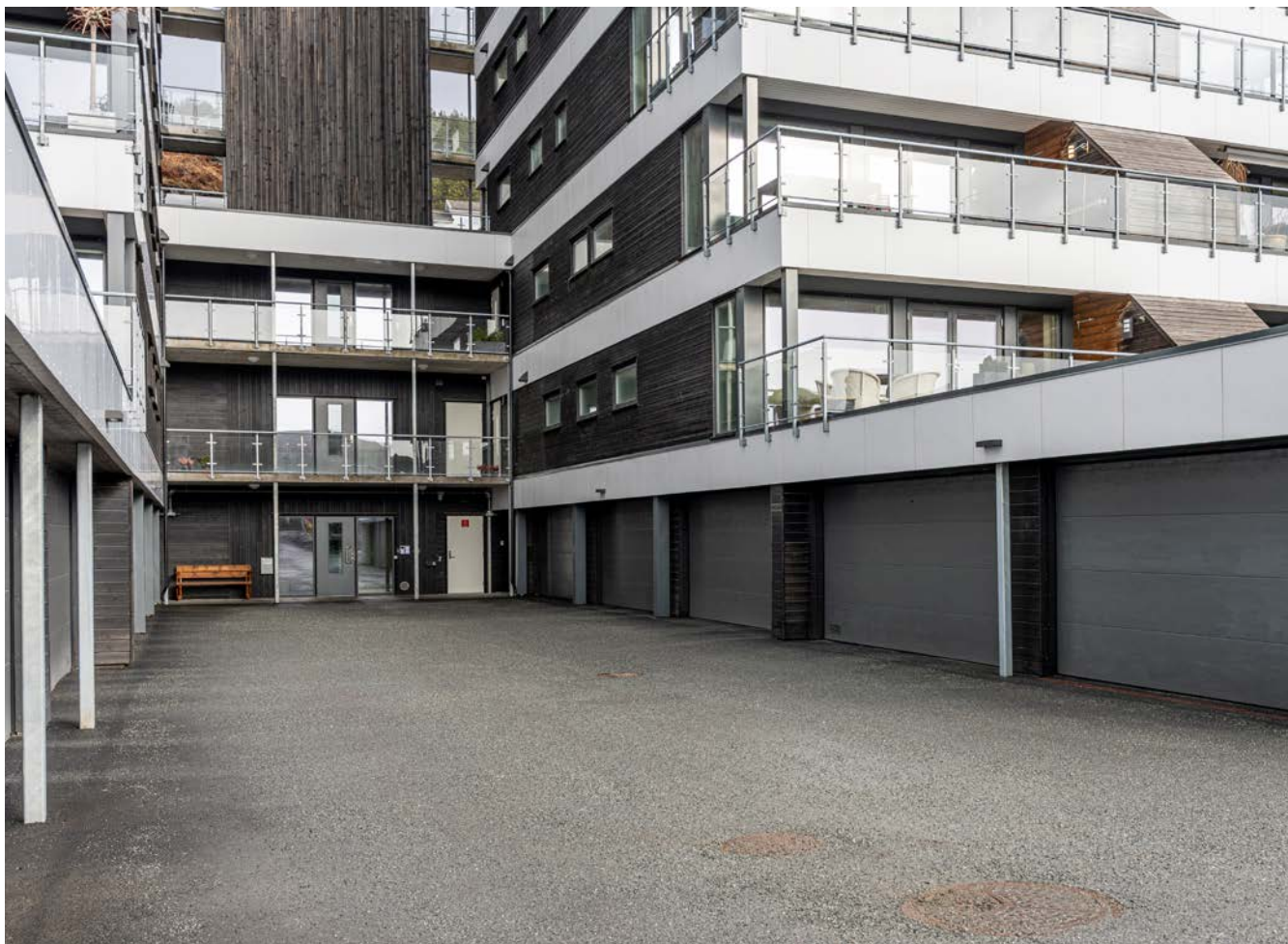
Inngangsparti og garasjer
