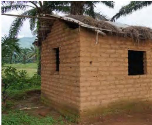
*Couverture en bâches et végétaux à proximité immédiate du VRI de Kigwena. On notera l'absence de soubassement et l'humidité excessive en pieds de murs, qui est très problématique pour la durabilité de la maison. Entre autres mesures, les abords de la maison doivent être impérativement travaillés pour permettre une évacuation très efficace des eaux de pluie. Crédit : AICRI*
