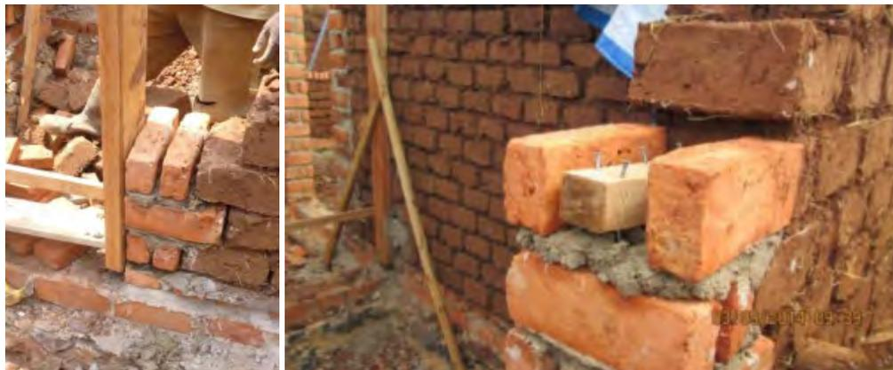
*La compatibilité des modules des briques cuites et des adobes permet une mise en œuvre efficace d'une maçonnerie mixte. Photographies extraites de PROECCO, 2015*
