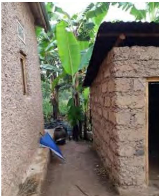
*Les débords de toiture sont trop faibles pour limiter les rejaillissements en pied de murs. Dans le cas des annexes, il est souvent beaucoup trop réduit pour protéger y compris la tête des murs. De plus, les pentes autour des constructions ne permettent pas une évacuation efficace des eaux de pluie.*
