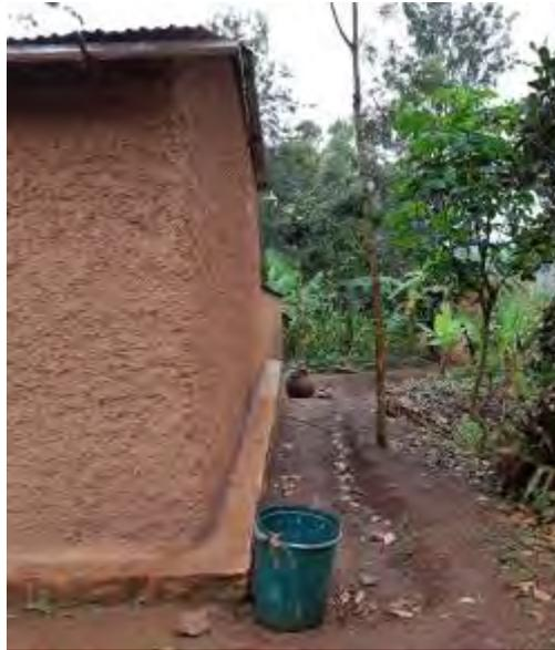
Le soubassement peut avoir la largeur du mur. Dans le cas où il est plus large, il faut prévoir une pente du débord de soubassement qui soit franchement vers l'extérieur pour éviter des stagnations d'eau au pied des murs.
