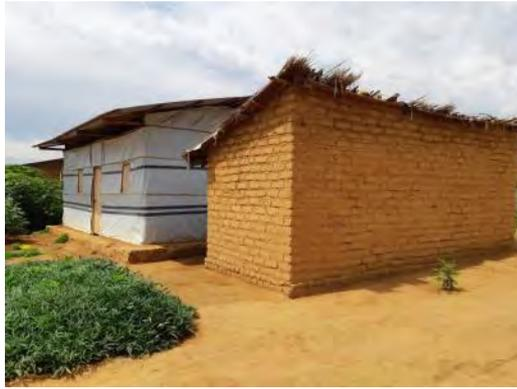
*Extension avec toiture végétalisée dans le VRI de Kigwena. On notera la hauteur importante d'un des murs, qui diminue sa stabilité.*
