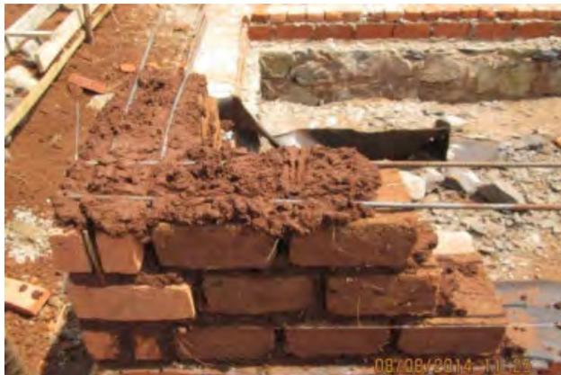
*Des fers à béton de diamètre 8 et de 1m de long sont insérés toutes les 3 ou 4 rangées d'adobe dans une maison modèle construite dans le cadre du programme PROECCO, au Rwanda. Ces maisons ont très bien résisté à un séisme de magnitude 5,6 ayant provoqué des dégâts sur les bâtiments limitrophes, à l'automne 2016<sup>79</sup>. Photographie extraite de PROECCO, 2015*
