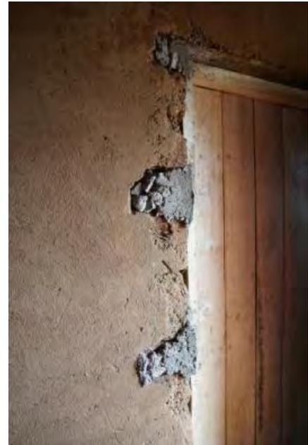
Une solution alternative peut être de maçonner les encadrements de portes avec des briques cuites, en insérant régulièrement des éléments bois ou métalliques entre les briques maçonnés au ciment. Les cadres de porte sont alors cloués à ces éléments bois. Cette solution technique demande à ce que les dimensions des adobes et celles des briques cuites soient compatibles.
