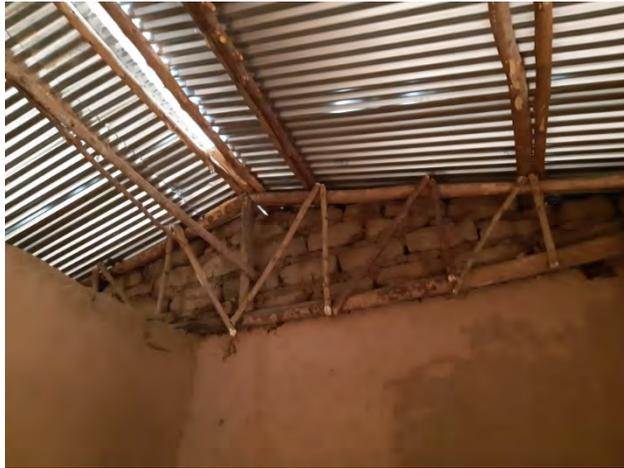
*Une ferme de la charpente se situe à proximité immédiate du mur pignon et peut faciliter un renforcement de cette partie très vulnérable de la construction. Pour les constructions à venir, il est conseillé d'utiliser cette ferme pour réaliser le triangle supérieur du mur en torchis.*
