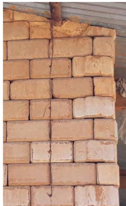
*Solutions locales d'ancrage de la charpente : grâce à un élément bois la reliant au linteau dans une extension construite par un bénéficiaire de la CRB à Muyinga (à gauche) – grâce à des moellons et à du fil de fer dans le VRI de Bohomba (à droite)*
