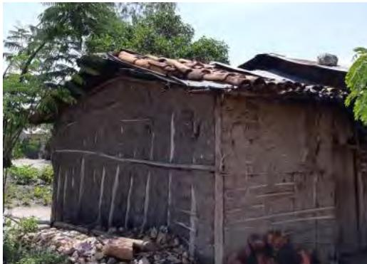
*Extension en torchis avec toiture tuiles dans le VRI de Bohomba (à gauche)*
