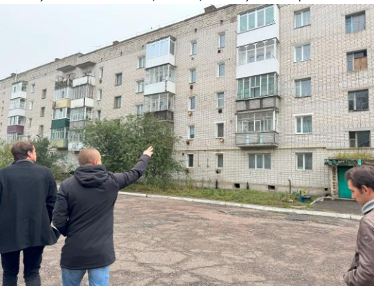
Сумська область, Свеса, статус: потребує ремонту
