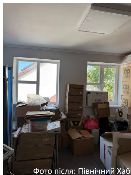
Фото до ремонту: Arche Nova
