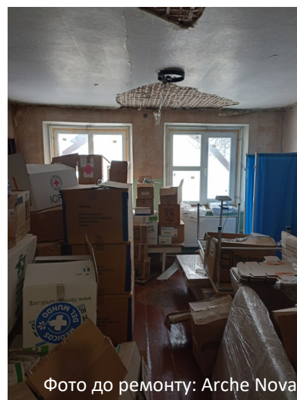
Фото до ремонту: Arche Nova
