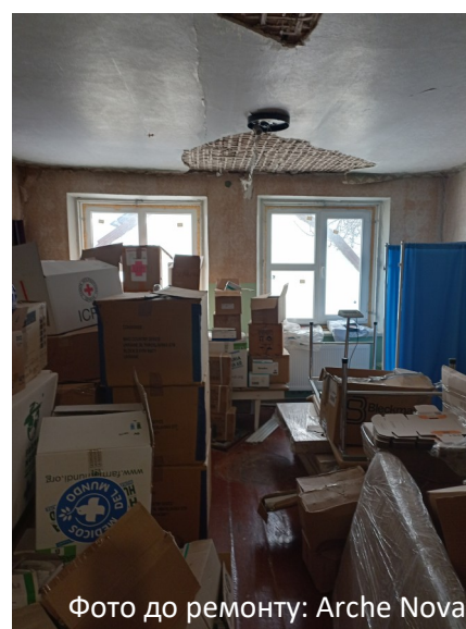
Фото до ремонту: Arche Nova
