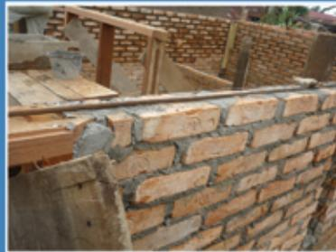
Pasang potongan besi pada setiap 1 meter ketinggian dinding bata dan masukan potongan besi paling tidak 50 kedalam dinding bata.
