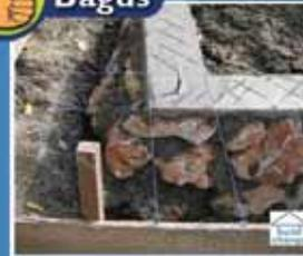
Jangan lupa untuk menggores bagian atas untuk kontak yang baik dengan sloof
