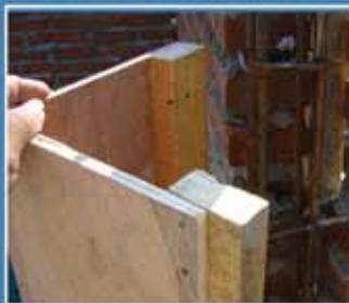
Persiapkan bekisting dan olesi dengan sika atau oli kotor pada bagian dalam bekisting
