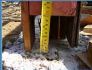
Gunakan kolom starter untuk menghindari kayu dari tanah dan air
