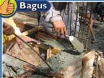
Untuk memadatkan campuran, tekan-tekan dengan batang kayu atau ketok mal dengan palu
