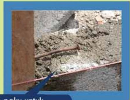
Gunakan bata, batako atau batu untuk membangun dinding bata bagian bawah. Perkuat dinding bata bagian bawah ke kolom kayu dengan paku.
