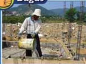
Basahi mal dan pondasi sebelum mengecor sehingga semen tidak diserap oleh mal
