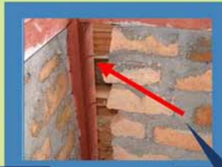
Gunakan paku untuk mengkoneksikan dinding bata dengan rangka kayu
