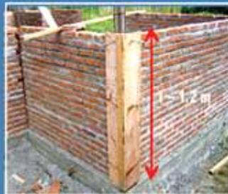
Lakukan pengecoran kolom ketika tinggi dinding mencapai 100 s/d 120cm
