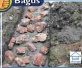
Jika kerja terhenti, pada bagian atas jangan ditutupi dengan mortar
