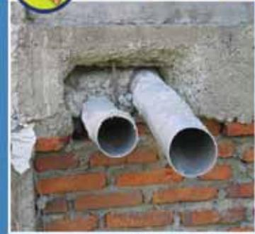
Pipa seharusnya tidak diletakkan menembus elemen beton bertulang seperti sloof atau kolom karena akan melemahkan bagian tersebut. Pipa sebaiknya diletakkan menembus dinding atau pondasi.
