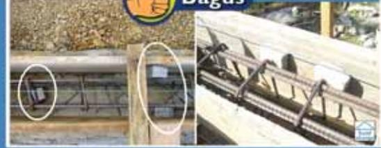
Letakkan beton tahu pada bagian bawah dan kedua sisi pembesian untuk memisahkan pembesian dari mal sehingga beton dapat menutupi pembesian dengan sempurna
