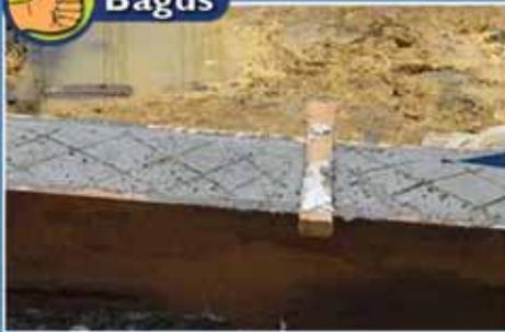
Jangan lupa untuk menggosok permukaan beton untuk ikatan yang baik dengan dinding
