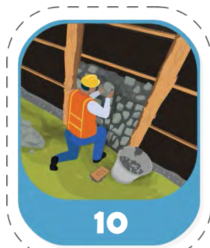
Réinstaller les pierres tombées. Mélange de mortier: 6 sable, 3 chaux, 2 ciment, 4 eau
