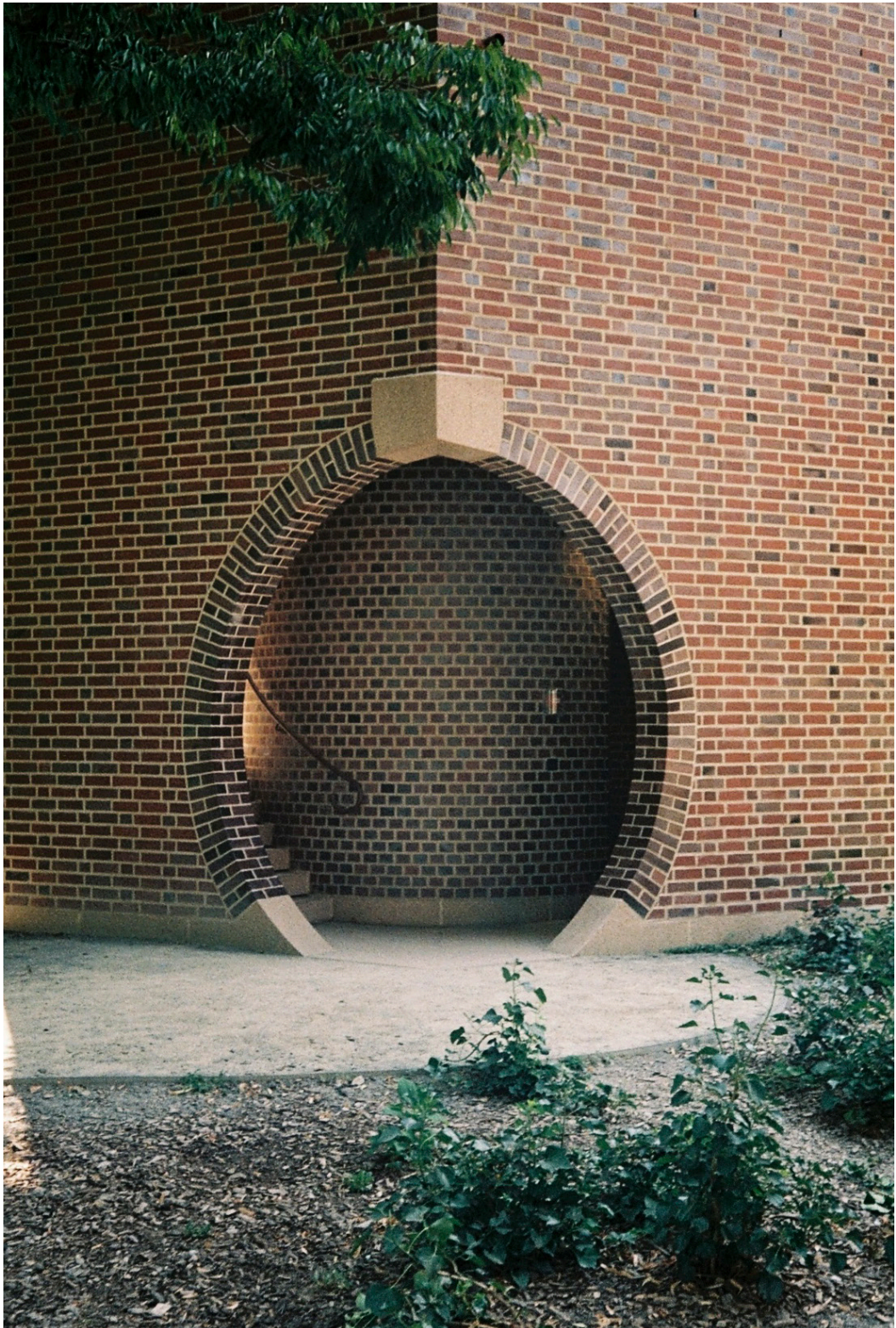
Fig. 12. Projekt 6, Hasselt Beguinage, entré till utkikstorn
