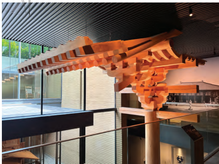
Modell i skala 1:1 av del från Hōryū-ji. Japanska tempel och shrines använder ofta ett system av konsolarmar för att fördela trycket och därmed kan ta större krafter.
