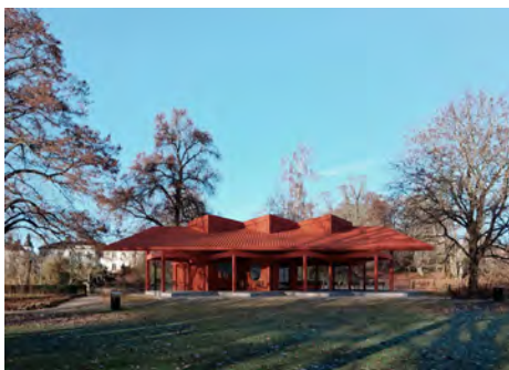
Aklejan Schiller Arkitektur Karl Schiller
