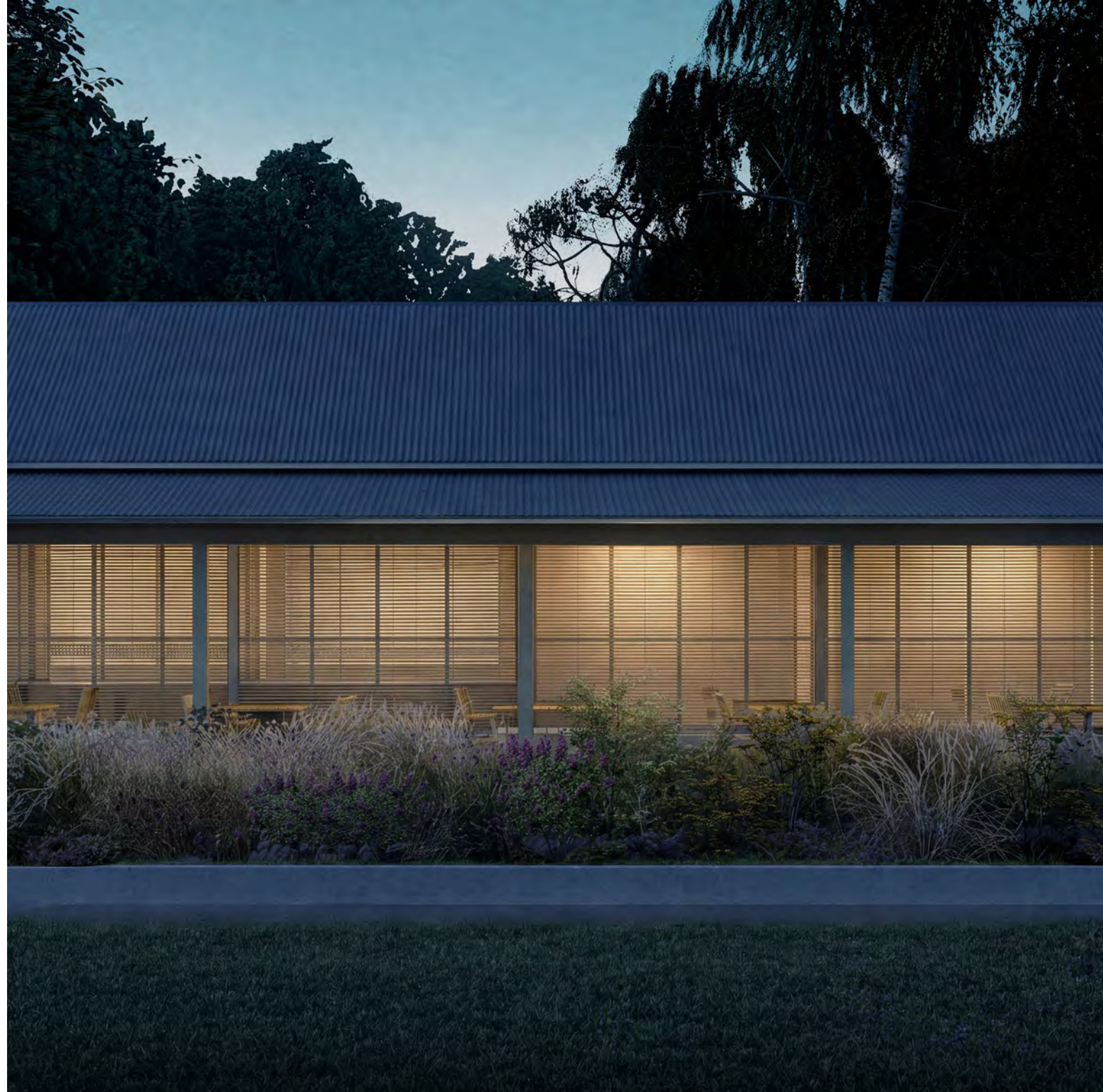
Även under vinterhalvåret, när caféet är stängt, fortsätter paviljongen att vara en del av parken. Som en mjukt upplyst lykta lyser den genom vinterkvällen och håller platsen levande året runt. Gatlyktor, belysningspollare och upplysta träd kompletterar paviljongen och skapar ett attraktivt parkrum även nattetid.
