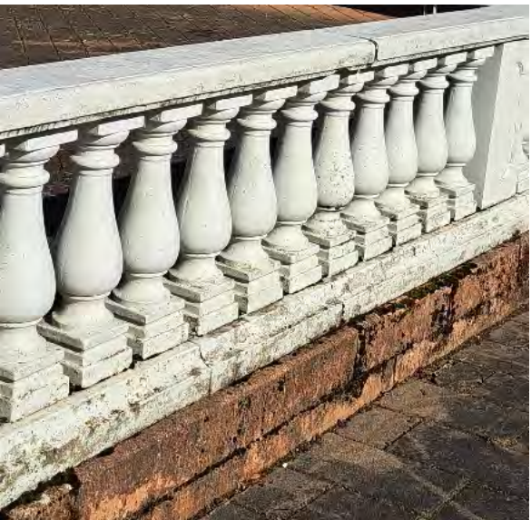
Bef. betongbalustrad som återbrukas
