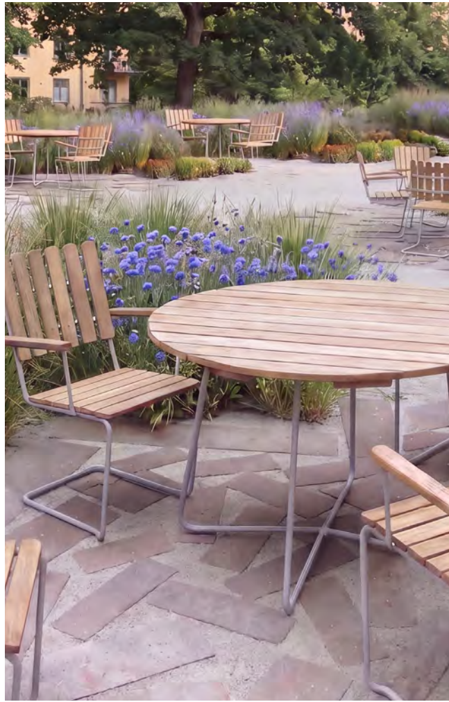
Återbrukade betongplattor i stenmjöl
