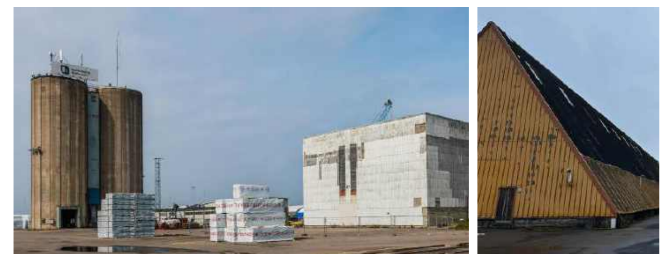
Platsen idag med befintliga byggnader. Silos som i förslaget inspirerar till cylindern. Eternitfabriken vars struktur bevaras och representerar klossen i de nya delarna. De stapelbara träförpackningarna som inspirerat modulariteten i förslaget.
