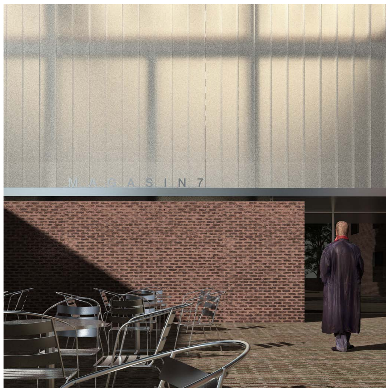
Translucenta glasprofiler släpper in dagsljus dagtid och låter den bevarade konstruktionen lysa som ett inre skelett kvällstid.
