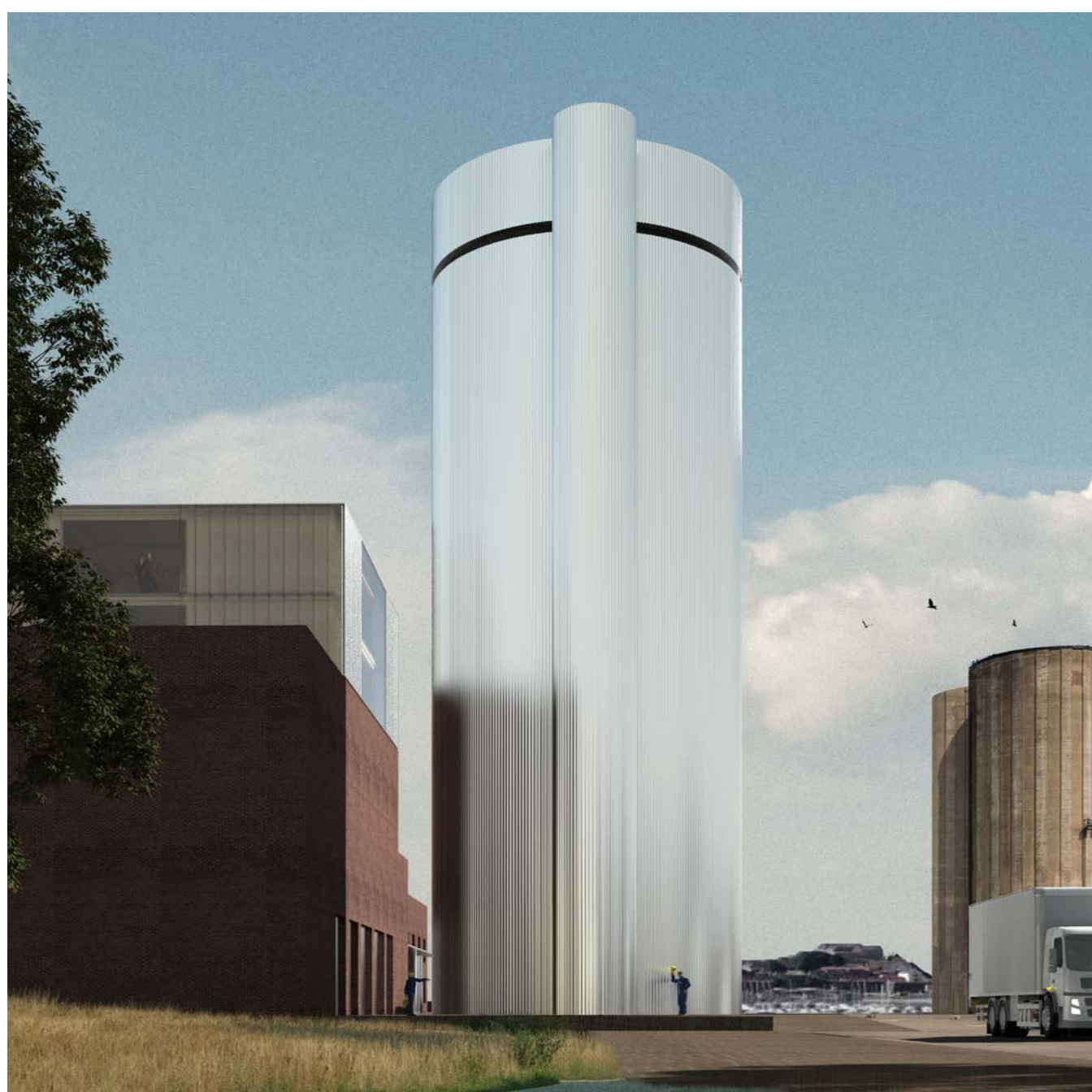
Den sinuskorrigerade aluminiumfasaden skapar ett levande ljusspel som anspelar på havets reflektioner och gör tekniken till en del av stadsbilden.
