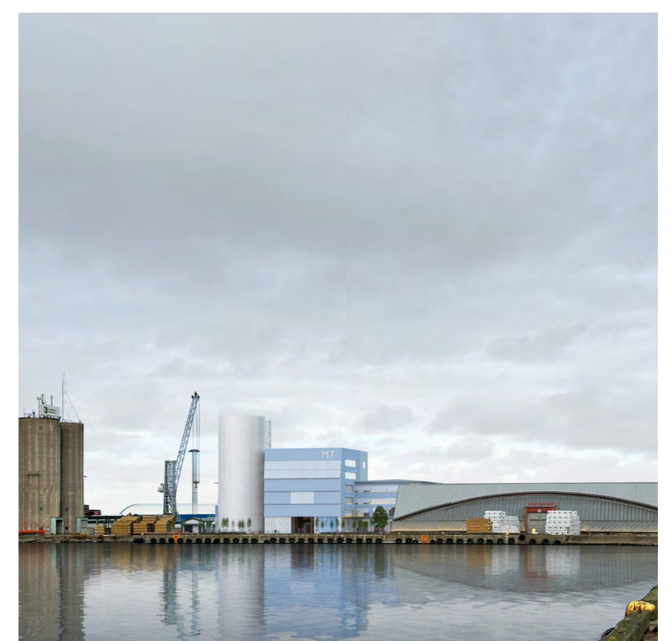
Fotopunkt 4. Nya Magasin 7 tar upp och vidareutvecklar den kubiska och monumentala volym som tidigare präglade platsen. Ackumulatortanken samspekar med de befintliga cementsilorna och förankrar byggnaden i områdets industriella karaktär.
