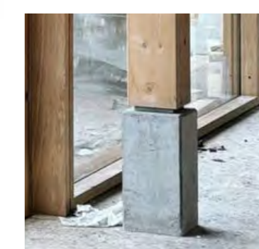
Trästomme på sockel av betong.
