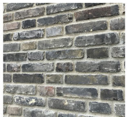
ÅTERBRUKSTEGEL PÅ FASAD
